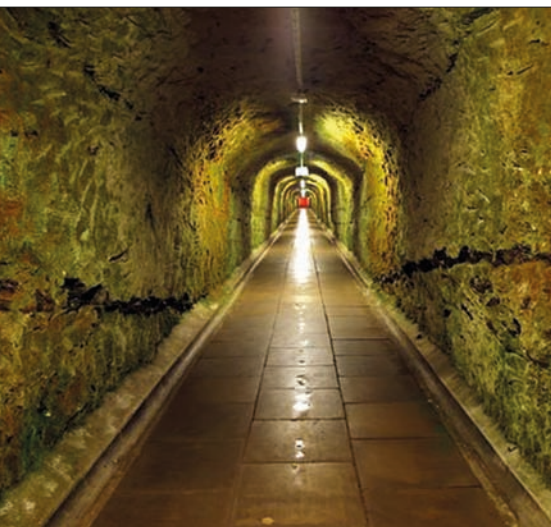
Fra Stevnfortet. Det underjordiske gangsystem er ca. 1,6 km langt og udhugget i undergrundens limsten.
